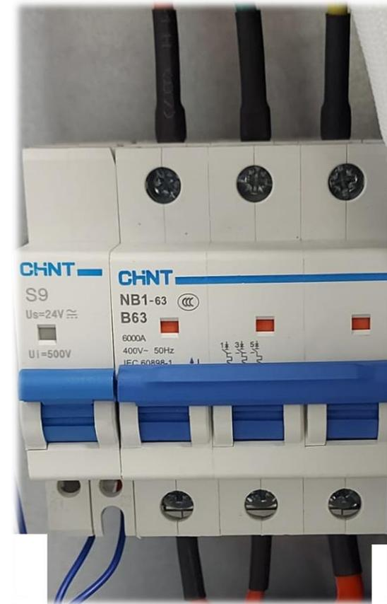
Автоматический выключатель, состоящий из выключателя NB1 и расцепителя S9, в данном случае выполняет функцию контактора.
